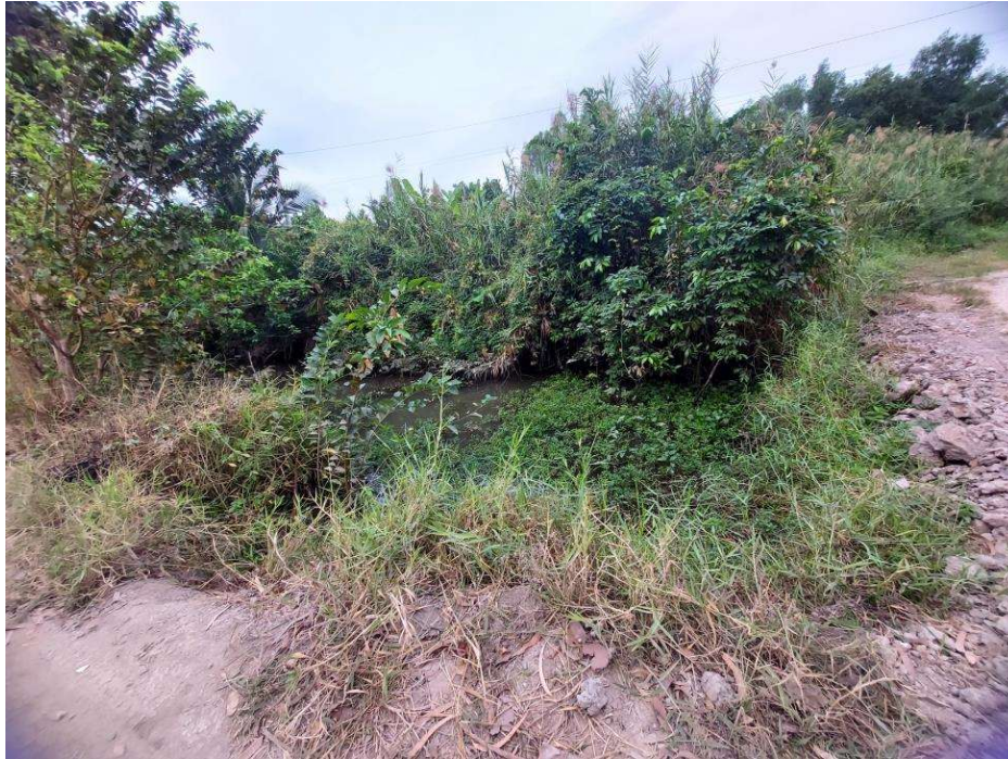
d. Mương nước nội đồng cắt ngang qua tuyến Quốc lộ 30 tránh thành phố Cao Lãnh
