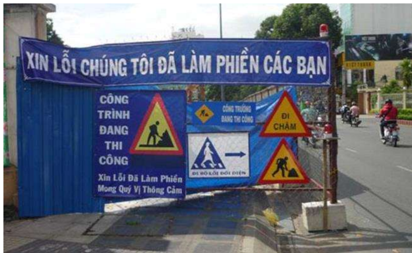
Hình 3. 6. Bố trí biển báo công trình đang thi công
